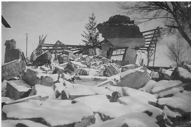
Руины на месте здания Нальчикского вокзала, взорванного немецко-фашистскими захватчиками в 1943 году. Фото Белоусова Н.Ф.
