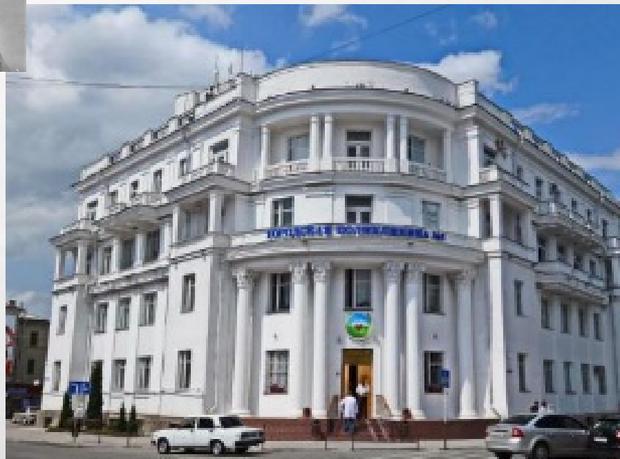
Восстановленное здание городской поликлиники
